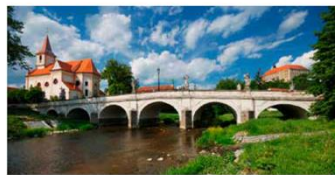
Řeku překlenuje barokní most se sochami světců (foto: Jiří Polehla)
