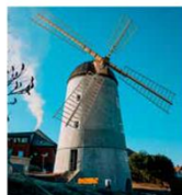
Třebíč se může pochlubit dalším unikátem: nově zrekonstruovaným větrným mlýnem na drcení kůry
